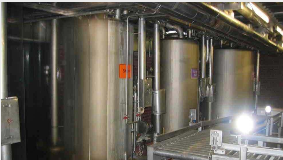
Оборудование CIP для кеговой линии
