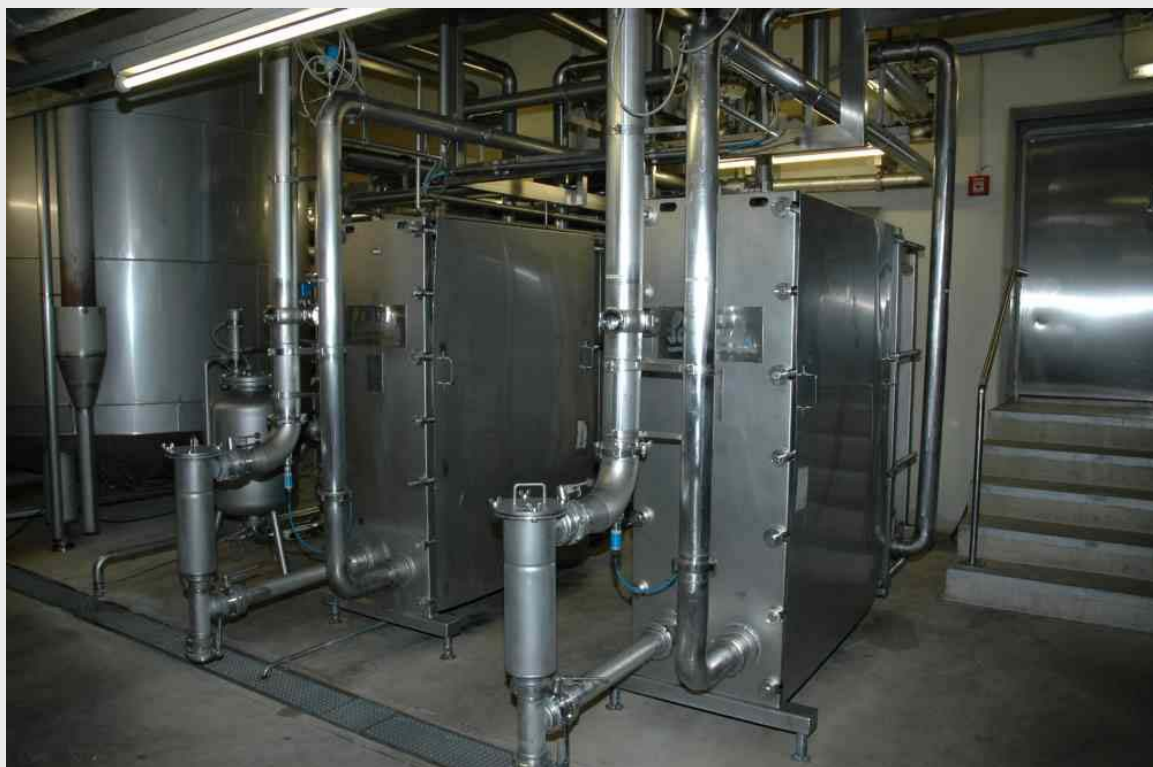
2 пластинчатых теплообменника
