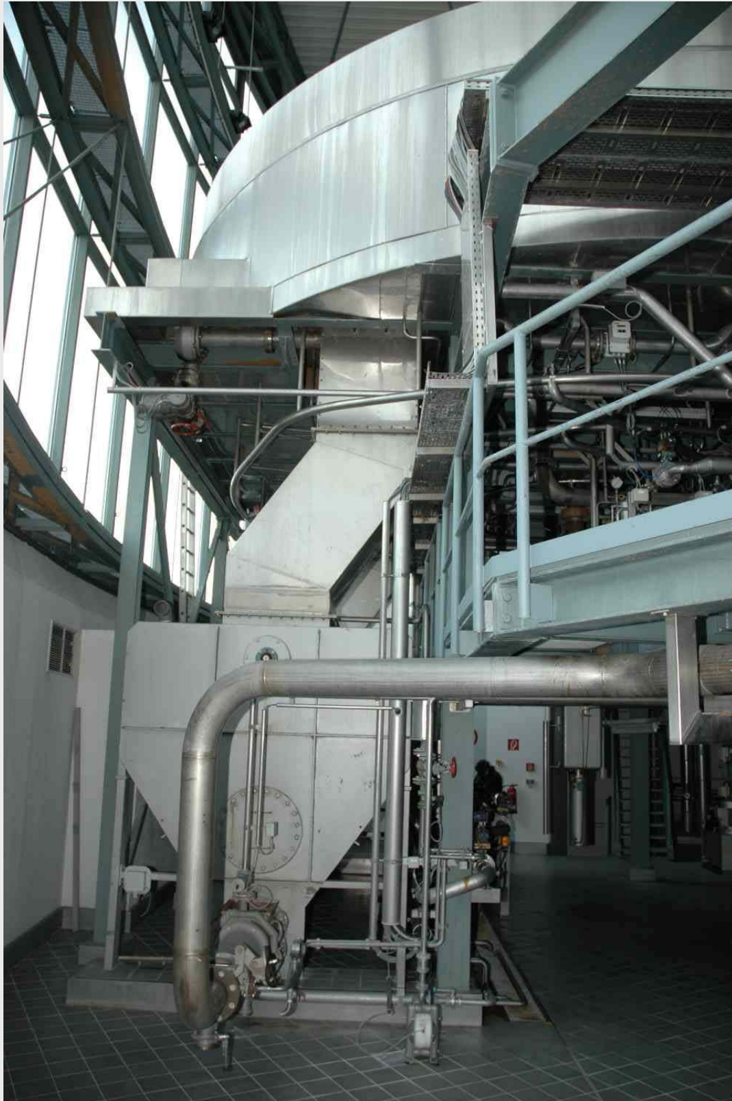
Фильтрационный чан и буфер для дробины
